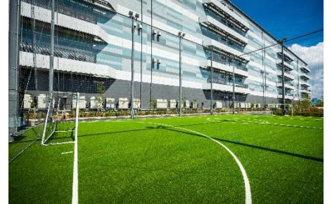
ドローンネットフィールド(フットサルコートとしても使用)
